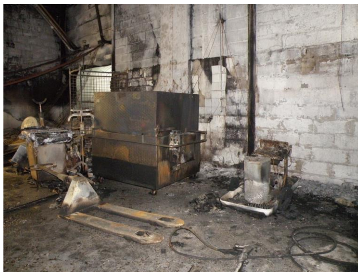
Figura 4: Vista para a parede do lado esquerdo
